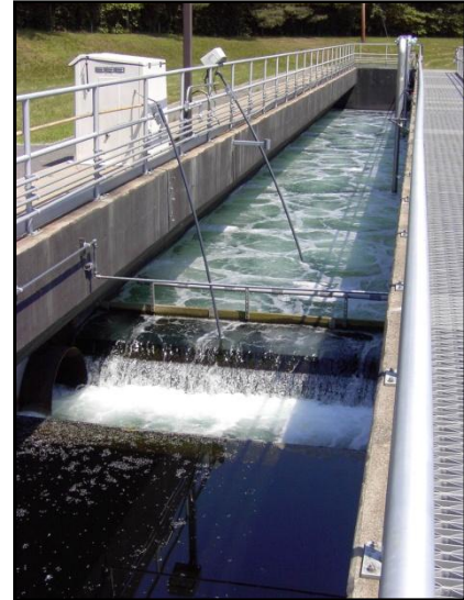
Post-Aeration & Effluent Discharge
